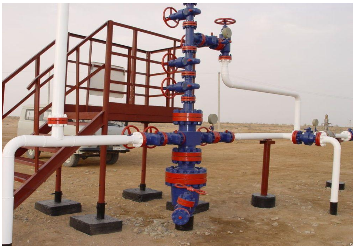
Сурет 3 - Кен орнындағы фонтанды арматура
